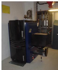
**Familie Bertram : Kombikessel für Stückholz + Pellet und Solvis Solarsystem für Heizung und Warmwasser und Solarstrom mit PV-Anlage 5,85kWp**
