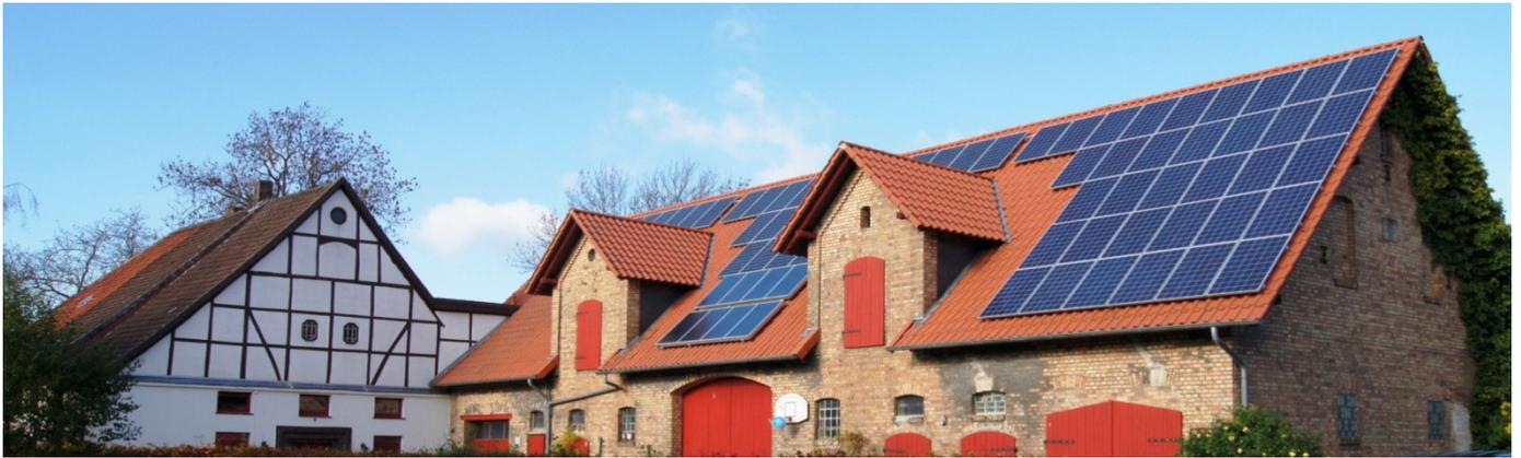
*Familie Wennin: Solvis Gas Max Solar-Brennwertspeicher 650 Liter mit 11,22m<sup>2</sup> Kollektorfläche und PV-Anlage mit Eigenstromnutzung 17,5 kWp*
